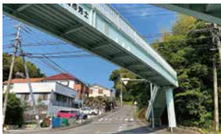
写真① 団地入り口の坂道 一番奥の建物は公民館
